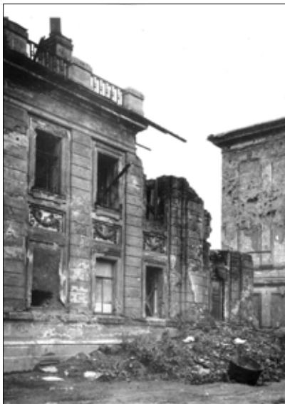
Ил. 1 Неизвестный фотограф Разрушенный дом № 7 Петропавловской крепости 1943–1945 Фотография ГМИ СПб
