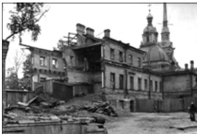
Ил. 3 Неизвестный фотограф Восстановление разрушенного дома № 11 Петропавловской крепости Конец 1940-х Фотография ГМИ СПб
