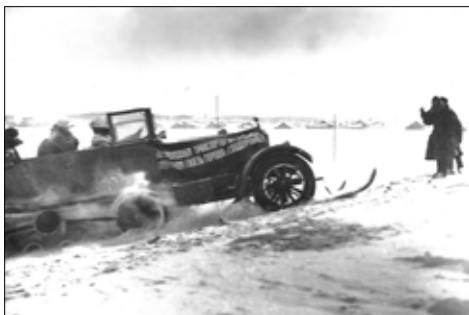
Ил. 3. Неизвестный фотограф. Испытания снегоходных машин на Воробьевых горах. Автомобиль «Роллс-Ройс» с двигателем Керресса 1931. Фотография РГАКФД
