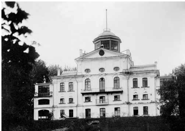
Ил. 17. Неизвестный фотограф Новознаменская дача. Фасад 1908. Фотография Из коллекции Музея Старого Петербурга ГМИ СПб
