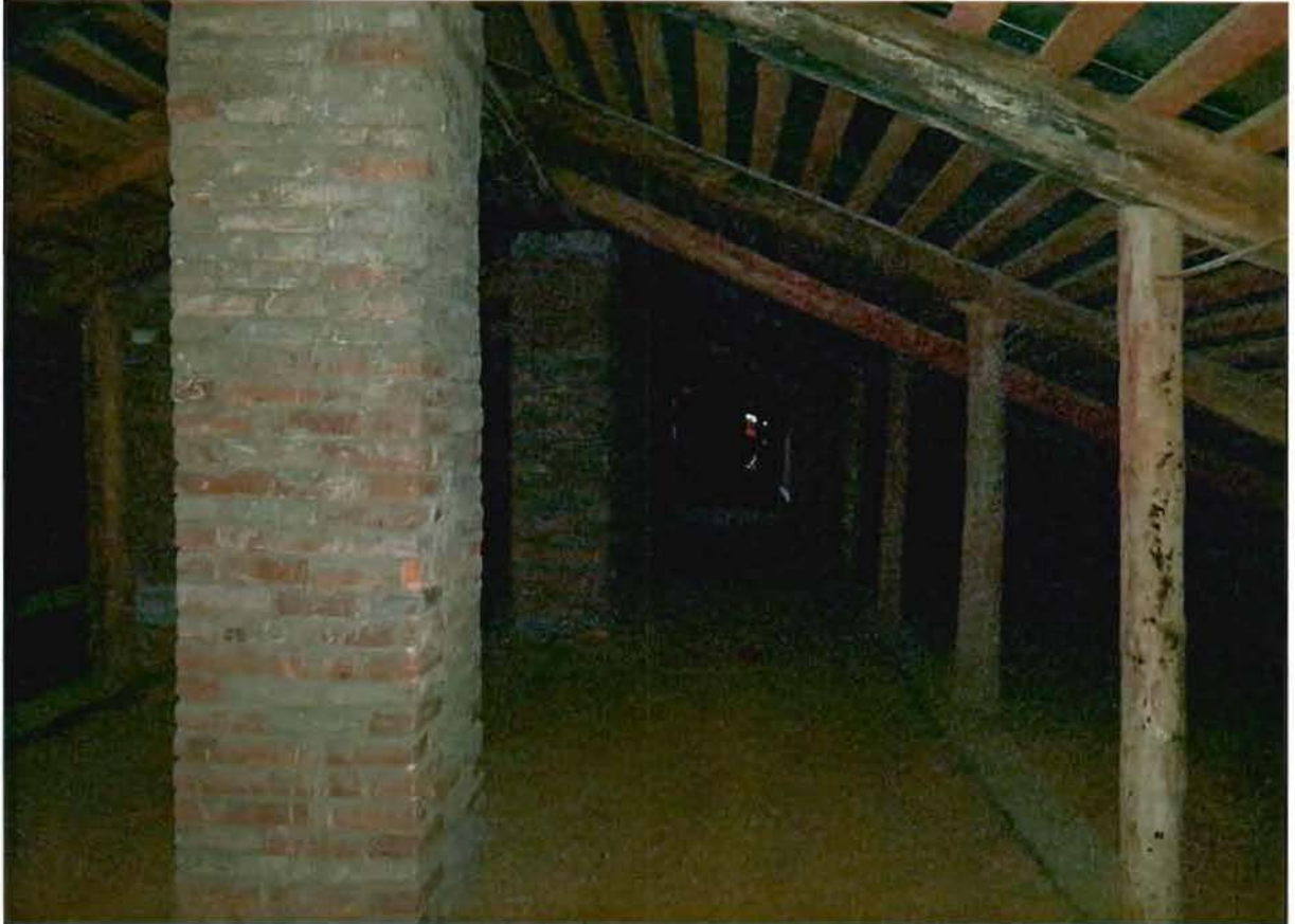
12. Фрагмент стропильной системы.
