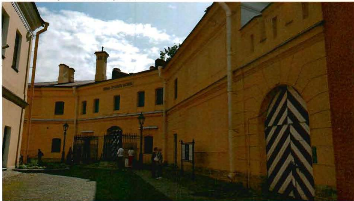
1. Вид на северо-восточный фасад.
