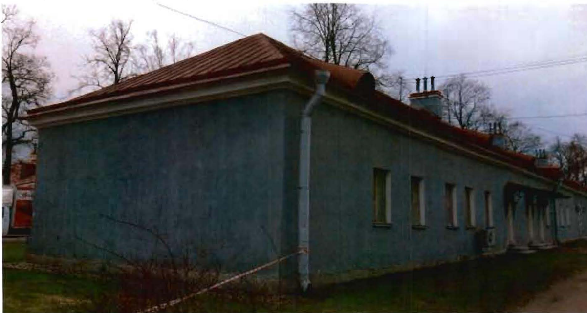
1. Вид на восточный фасад.
