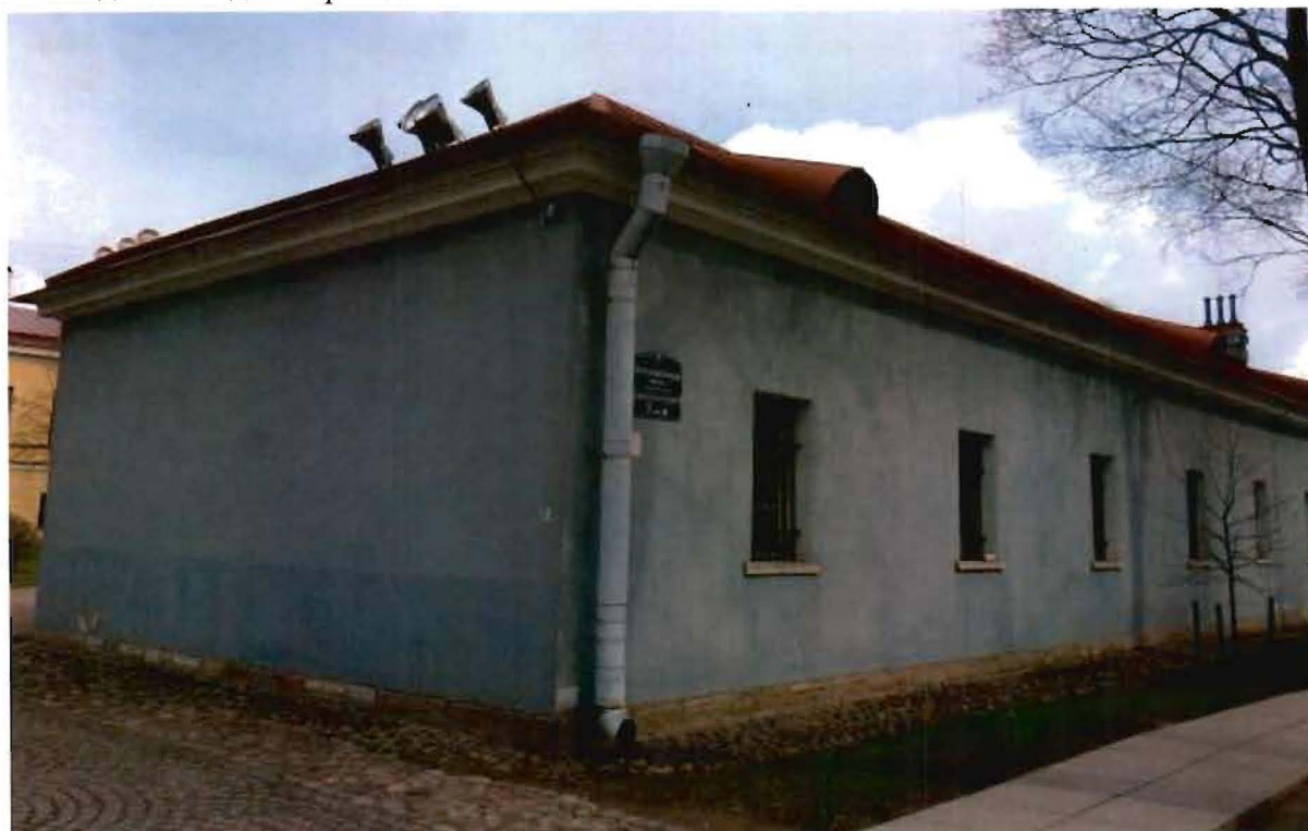
2. Вид на западный фасад.
